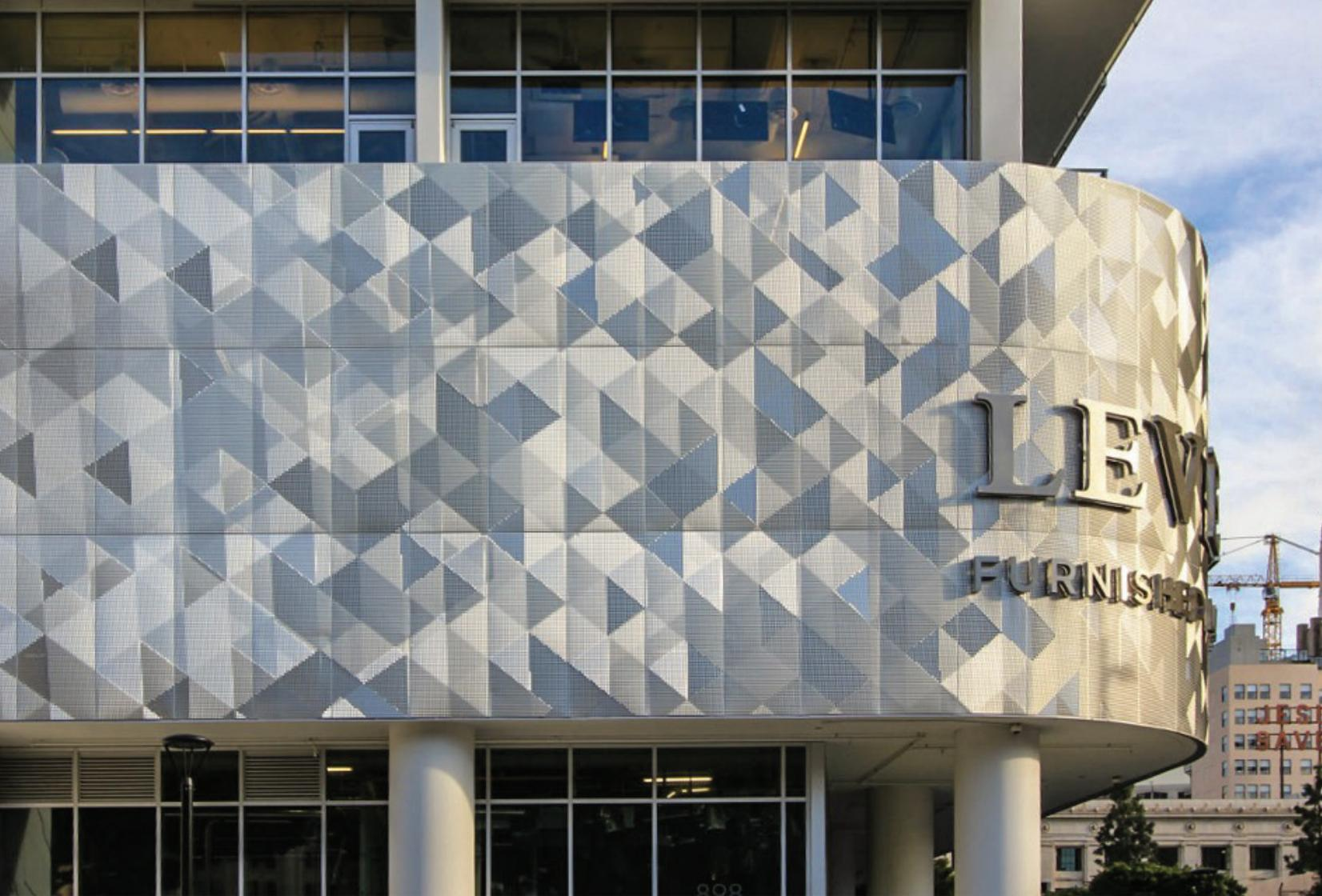
Durch das im Projekt in der Olive Street 888 verwendete Ombrae-System wurde sichergestellt, dass der Innenraum durch die schrägen Löcher in der Platte belüftet wurde und das ästhetische Erscheinungsbild der Außenseite durch die Licht-/Schatteneffekte auf der Oberfläche der Aluminiumplatten gestaltet wurde.
