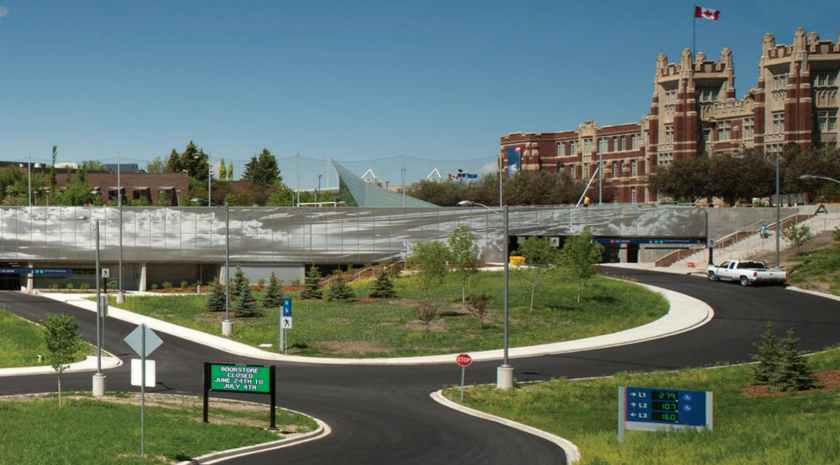
Die Fassadengestaltung wird zwar in Übereinstimmung mit dem Konzept des Projekts mit Ombræ umgesetzt, aber das Sonnenlicht wird durch die Löcher in der Platte gefiltert. Das System erzeugt durch die im Inneren entstehenden Schatten Spiegelungen im Fassadenmuster und ermöglicht auch die Beleuchtung des Innenraums.
