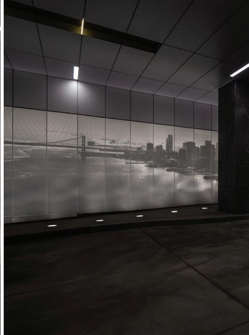
Kleinere Pixelgrößen sind besonders für detailliert gestaltete Projekte zu bevorzugen. Um die Wahrnehmung des Designs aus kurzer Entfernung zu erleichtern, werden daher im Eingangsbereich der Garage des VGNC Hospital kleinere Pixelgrößen verwendet.
